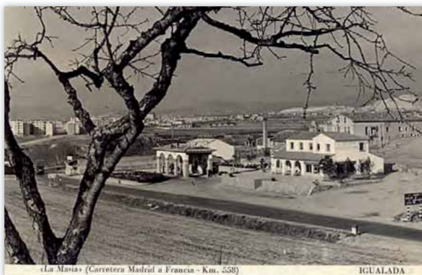
La Masia (Carretera Madrid a Francia - Km. 558)
