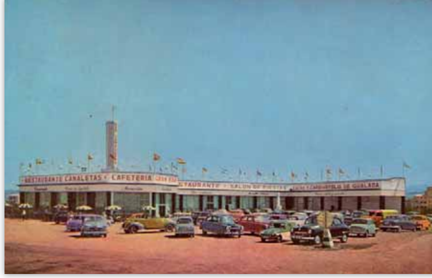
Bar Restaurante Canaletas Gran aparcamiento frente a la fachada
