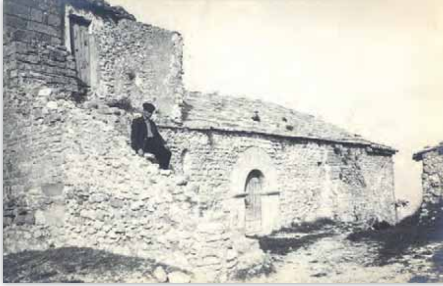
La Tossa de Montbui L'èrmita abans de la restauració
